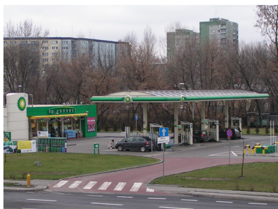
System fotowoltaiczny na stacji BP na Wale Miedzeszyńskim
