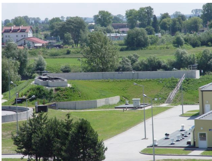
Koryto pomiarowe i przelew burzowy
