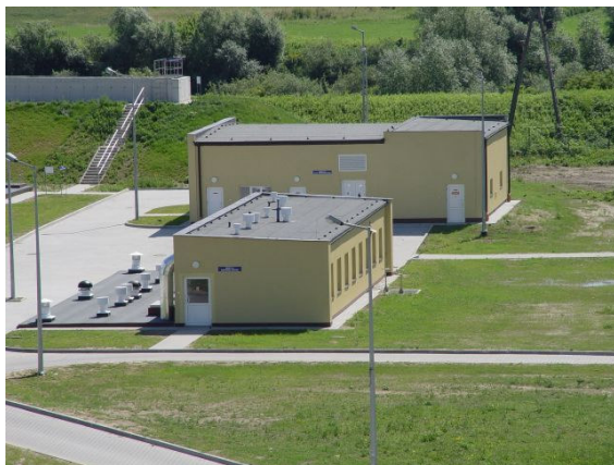
Pompownia ścieków i budynek zaplecza energetycznego
