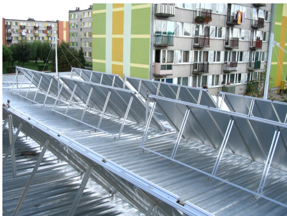
Instalacja słoneczna z kolektorami na wsporczej aluminiowej konstrukcji wolnostojącej
