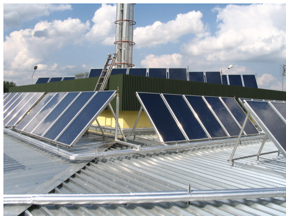
Instalacja słoneczna z kolektorami na wsporczej aluminiowej konstrukcji wolnostojącej
