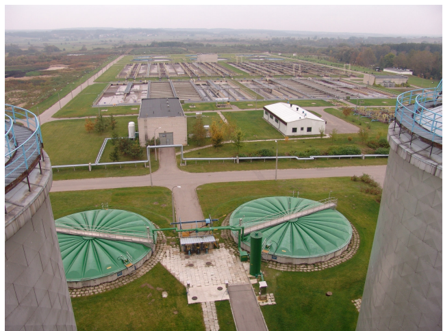
Oczyszczalnia ścieków w Białymstoku
