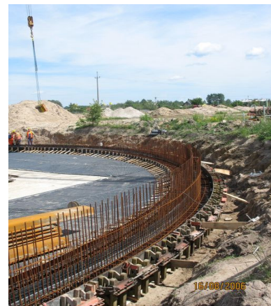
Stan budowy oczyszczalni w dniu 16.08.2006 r.
