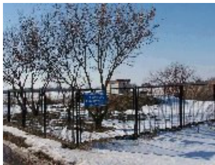
Ujęcie wody – studnia
