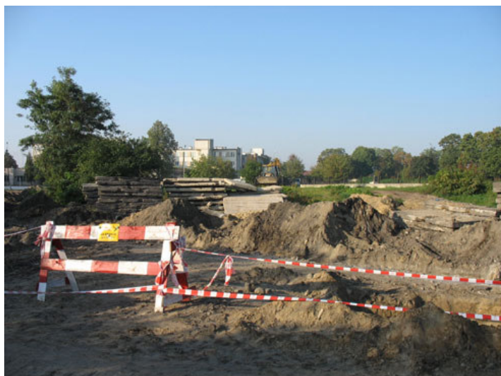
ul. Nowa - Dolna - Rzeźniana budowa wodociągu, kanalizacji sanitarnej i deszczowej z odbudową ulicy
