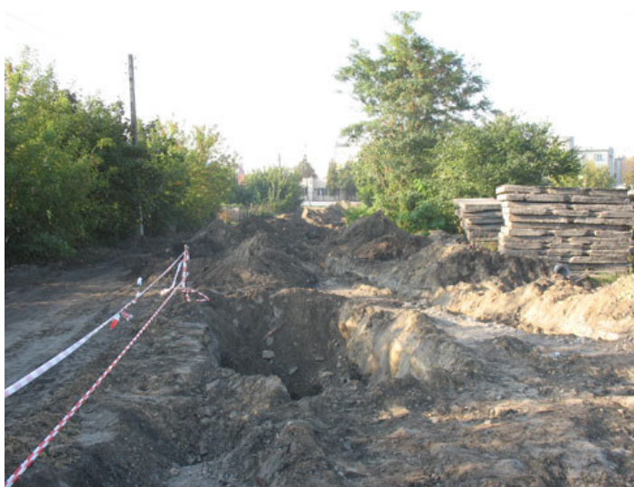
ul. Nowa - Dolna - Rzeźniana budowa wodociągu, kanalizacji sanitarnej i deszczowej z odbudową ulicy
