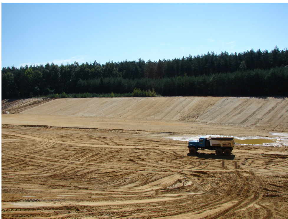
Składowisko w budowie
